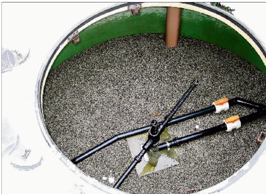
Im Sandfilterbehälter wird das Abwasser durch den Drehsprenger gleichmässig verteilt. (Bild Paul Küchler)
